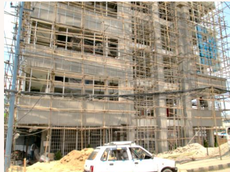
Bauweise mit Bambuspfählen
